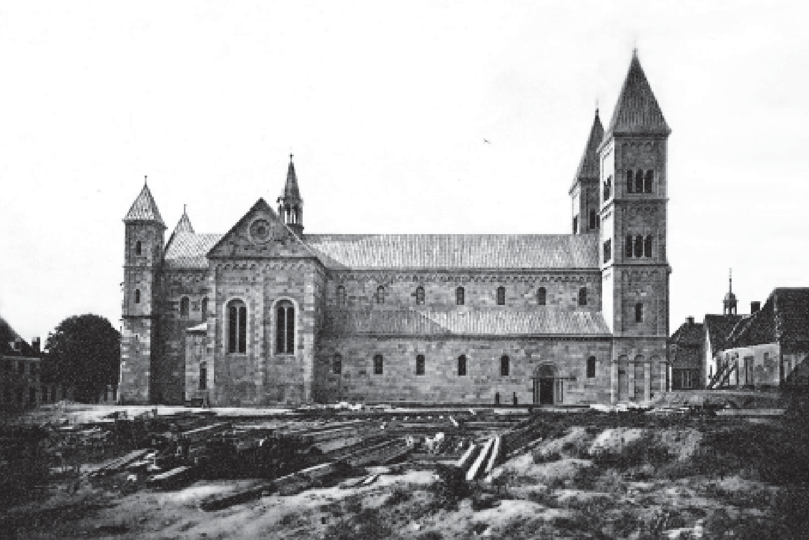
Foto fra mellem 1871 og 1875, der viser omfattende reguleringsarbejde på nordsiden af domkirken (bemærk afgravningskanten ud for Domkirkens nordvesttårn.)
