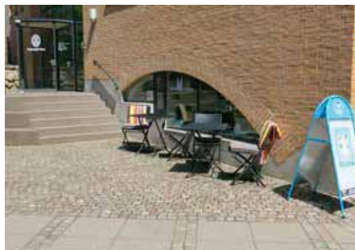
Belægningerne ved Sognegården harmonerer ikke med resten af Gammeltorvs belægning.
