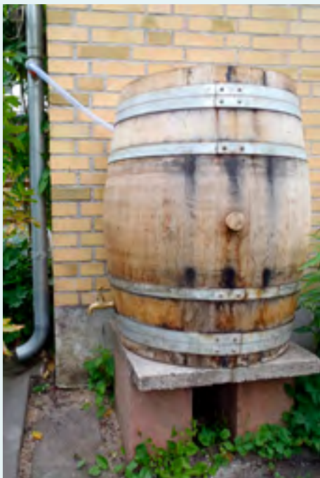
Regnvandstønden fyldes op via nedløbsrøret. Foto Orbicon.
