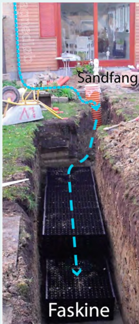
Faskine under udførelse. Tagvandet ledes via en sandfangsbrønd (lodret orange rør) til faskinen i billedets forgrund. Denne faskine er opbygget af plastkassetter. Foto Spildevandscenter Avedøre.
