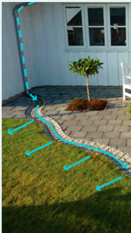
Regnvand ledes i en tæt rende bort fra huset til nedsivning i græsplænen. Foto Orbicon.
