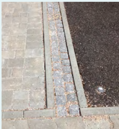
Gennemtrængelig belægning med fliser og asfalt. Svanemøllehallen, Københavns Kommune. Foto Orbicon
