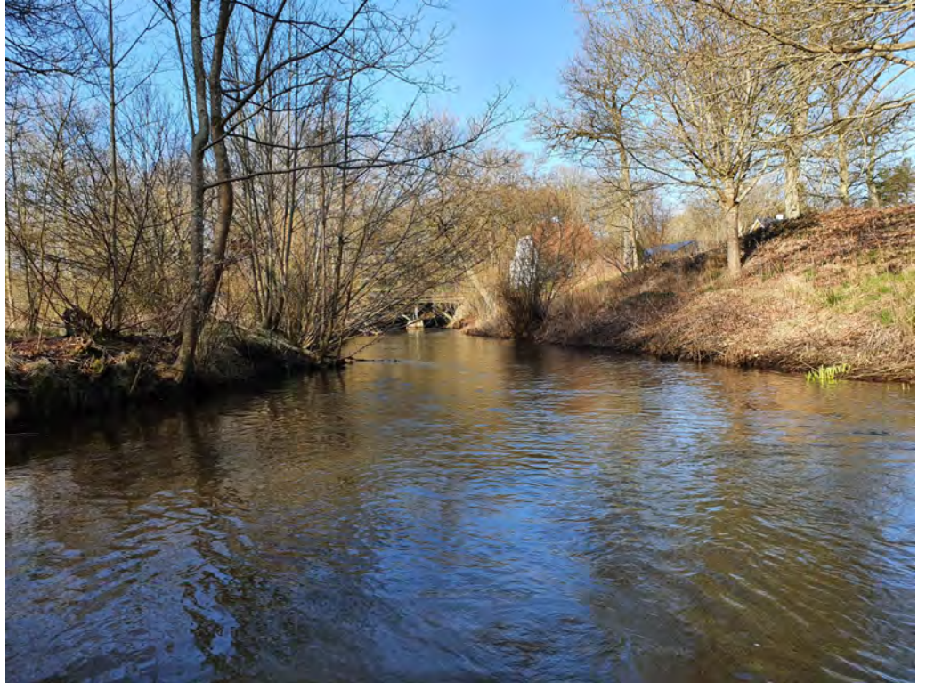
Figur 9 Strækningen ved lokation 1. Foto taget i ca. st. 455 m, mod vest.
